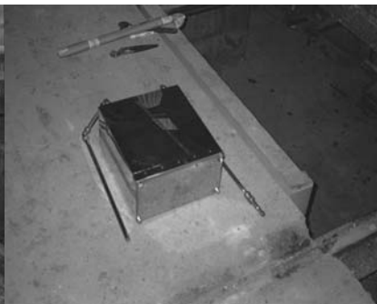
Points d'alimentation et de trop-plein raccordés à la partie avant du wagon du four
