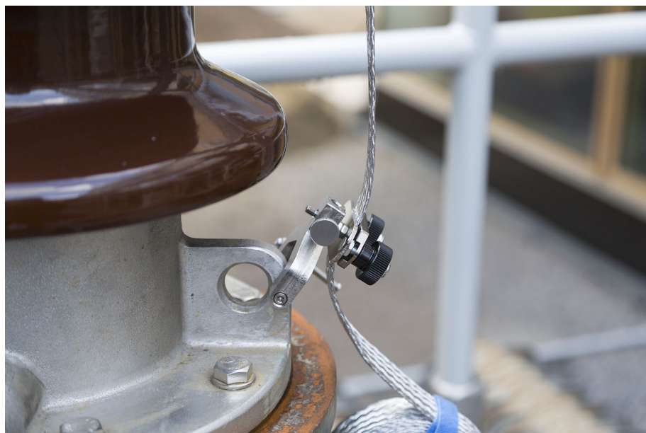
Фигура 4-6: Алтернативен начин за закрепване на винтовата скоба
