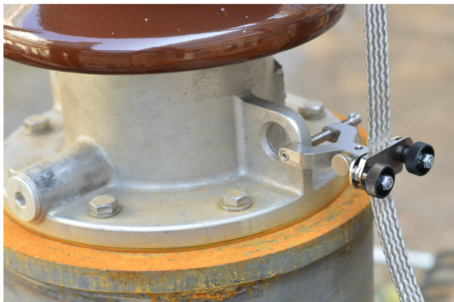
Фигура 4-5: Закрепване на винтовата скоба
