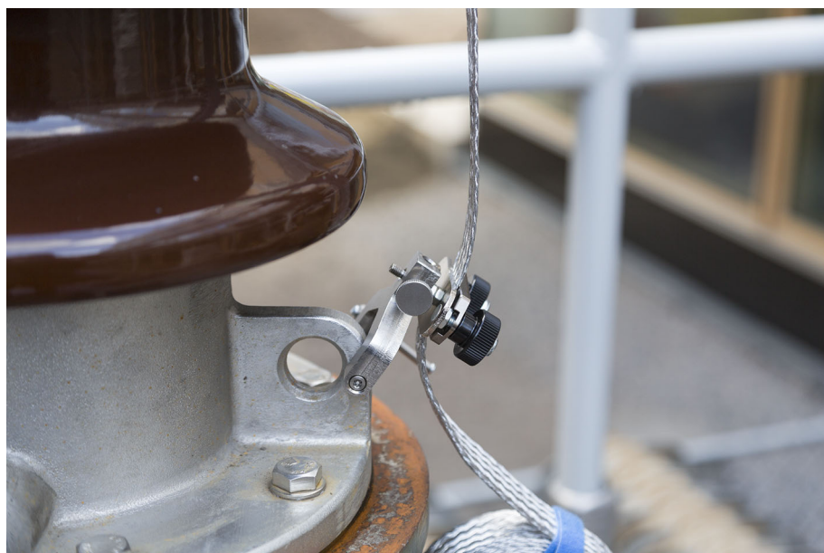
Figura 4-6: Serraggio alternativo della staffa a vite
