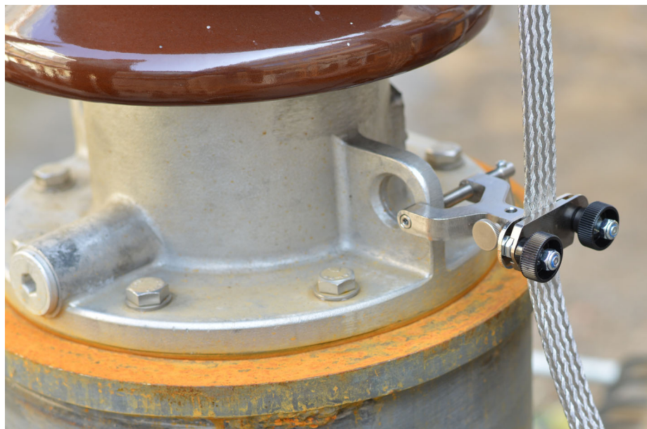
Figura 4-5: Serraggio della staffa a vite
