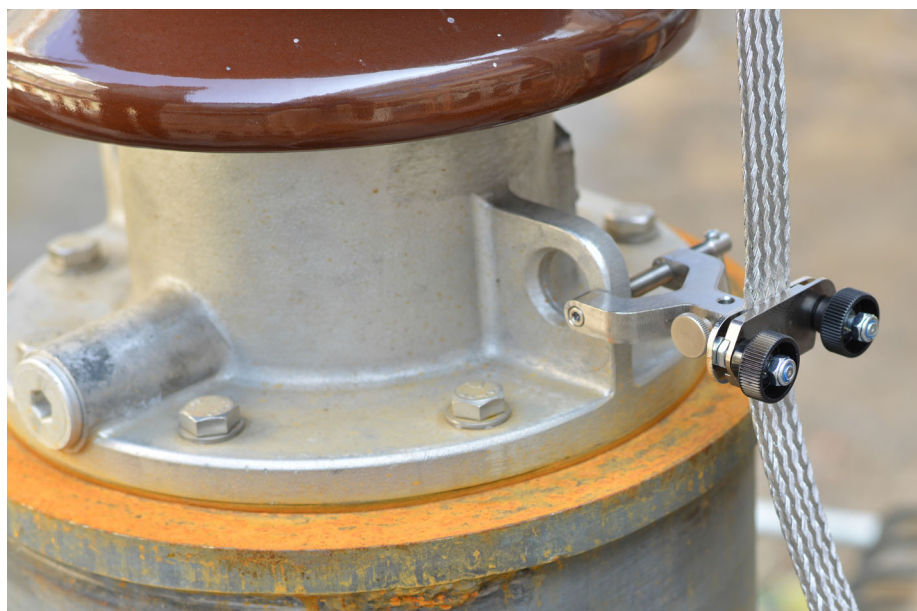
Figura 5-5: Fijación de la pinza de tornillo
