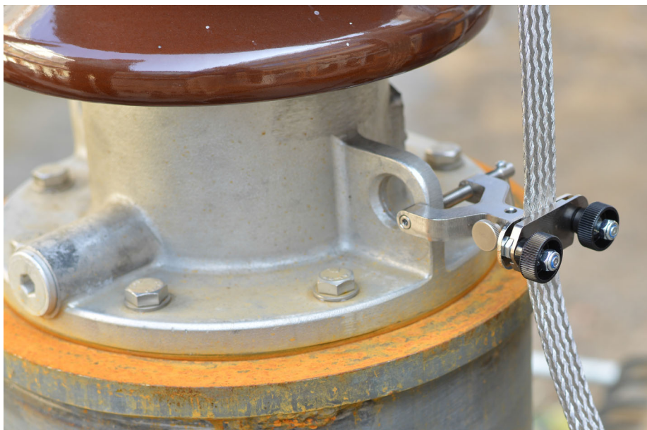
Figura 5-5: Apertando a braçadeira de parafuso
