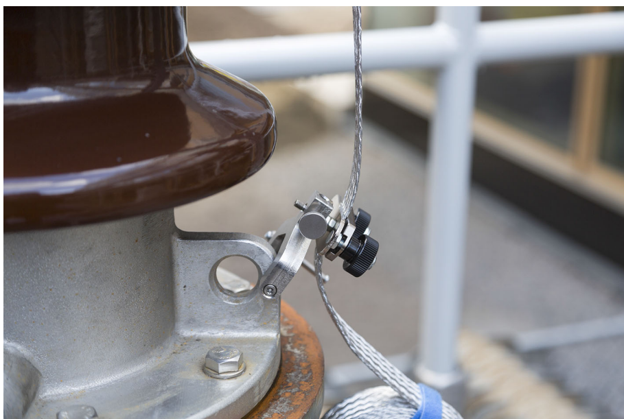
Figura 5-6: Maneira alternativa de apertar a braçadeira de parafuso
