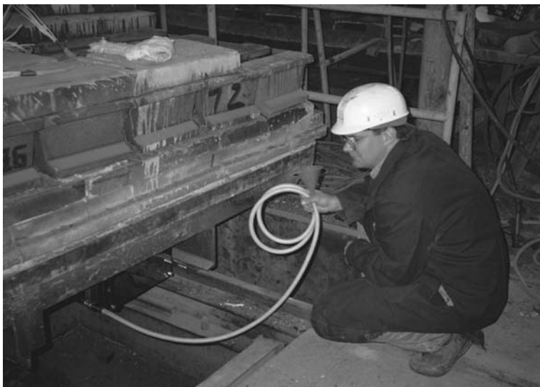
Llenado de la barrera térmica antes de una prueba.
