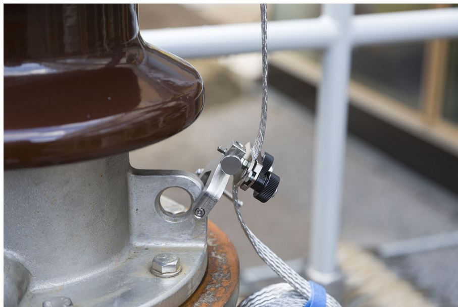
Rysunek 4-6: Inna metoda dokręcania zwornicy śrubowej
