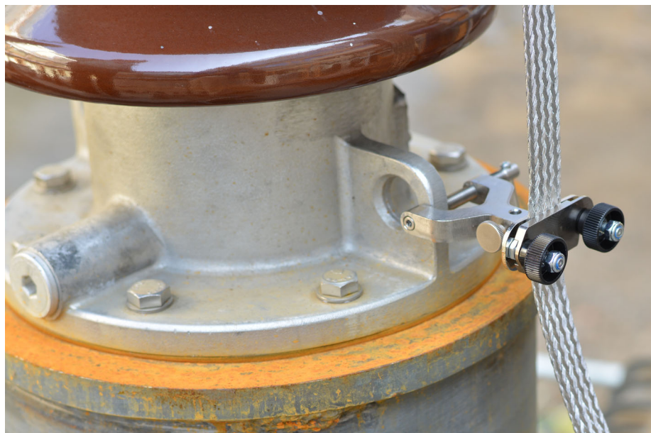
Rysunek 4-5: Dokręcanie zwornicy śrubowej
