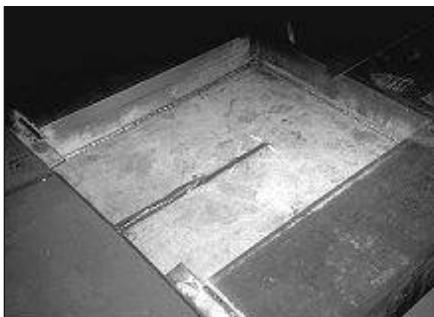
Les brames installées avec des barres de maintien (gauche) et une plaque d'acier soudée (droite) pour servir d'appui à l'assemblage du bouclier thermique dans la découpe.
