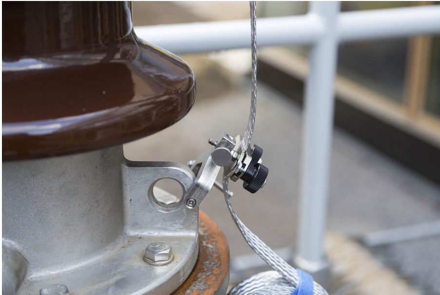
Şekil 4-6: Vida klampını sıkmanın alternatif yöntemi
