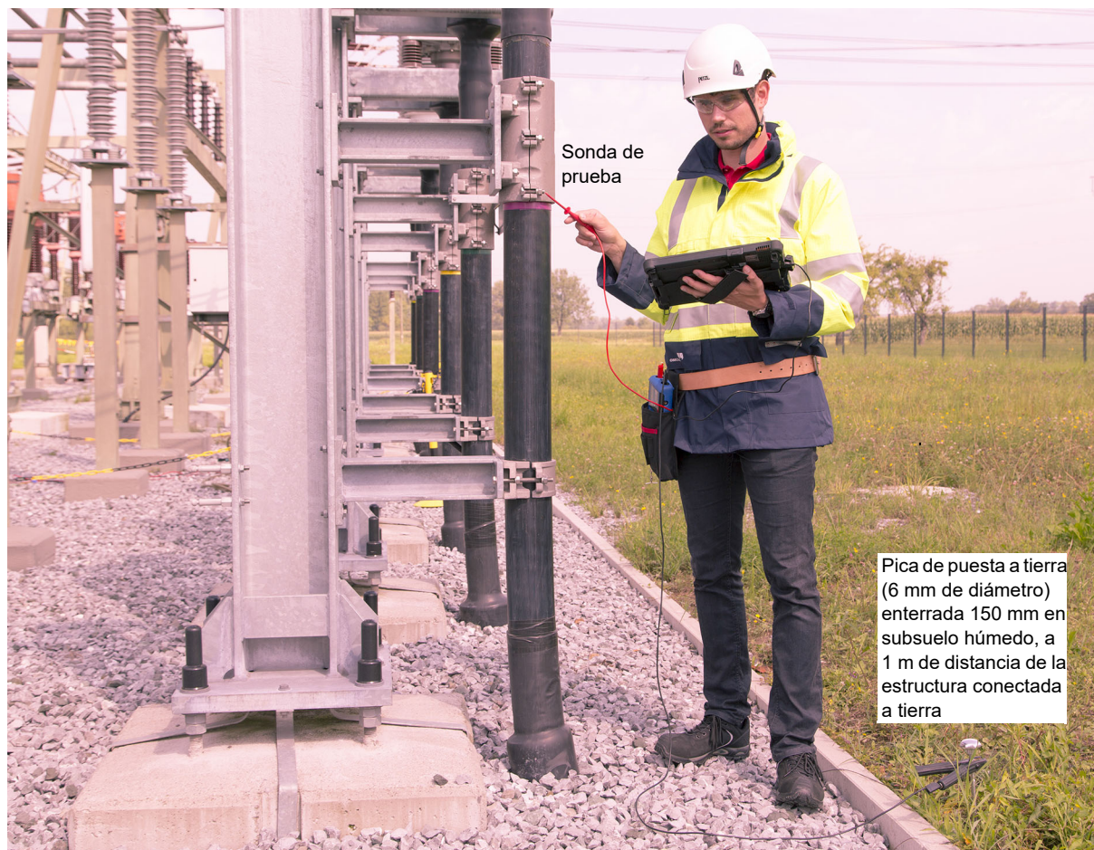
Figura 8-12: Medición de tensión de contacto con PTM (tableta) según IEEE 81
