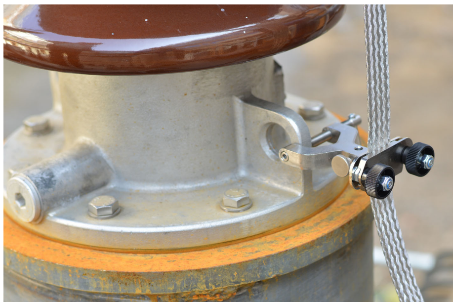
Figure 4-5: Serrage de la pince vissable
