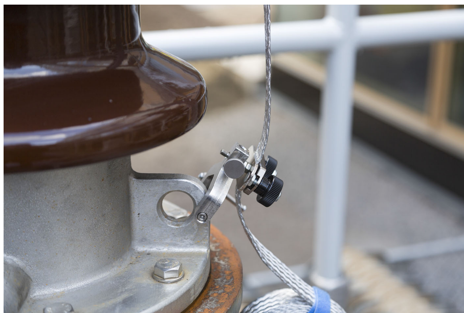
Рис. 5-6: Другой способ крепления с помощью винтового зажима
