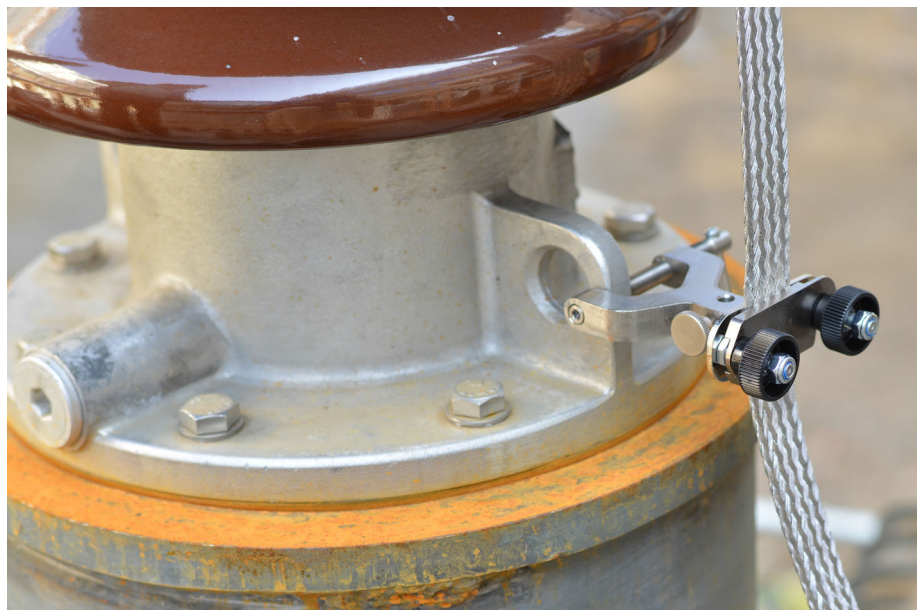
Рис. 5-5: Крепление ленты с помощью винтового зажима
