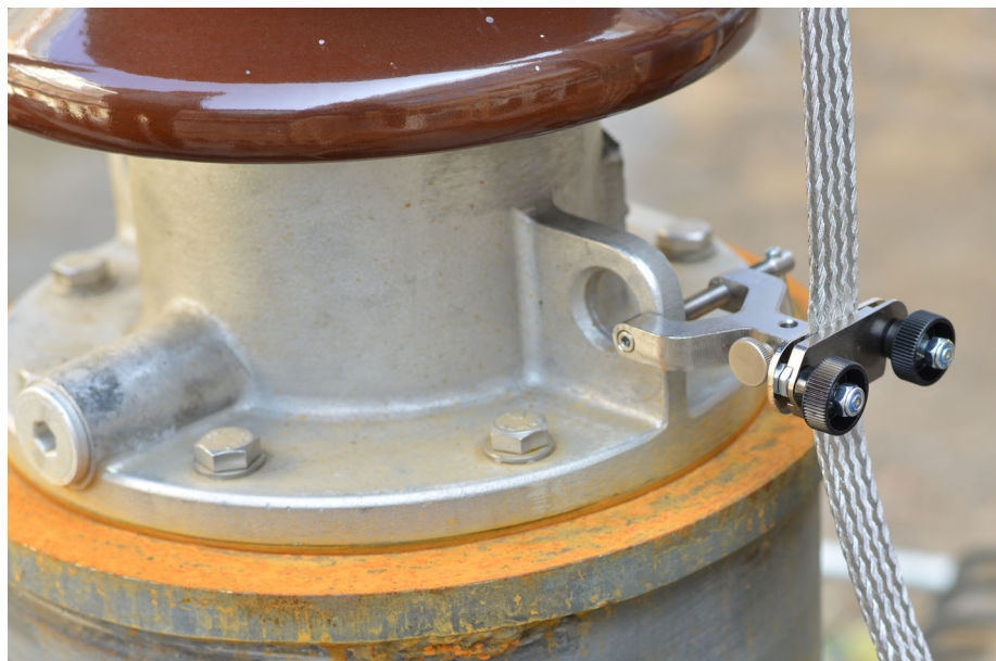
Figur 4-5: Fastgør skrueklemmen
