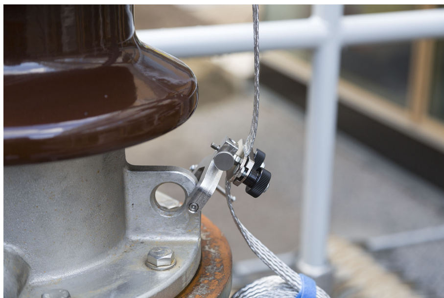
Figur 4-6: Anden måde at fastgøre skrueklemmen
