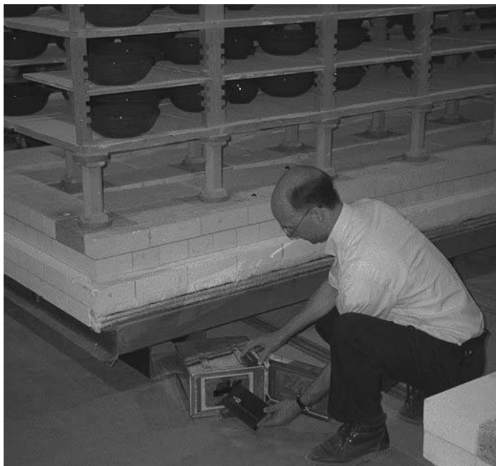
Installazione del registratore dati nella barriera termica
