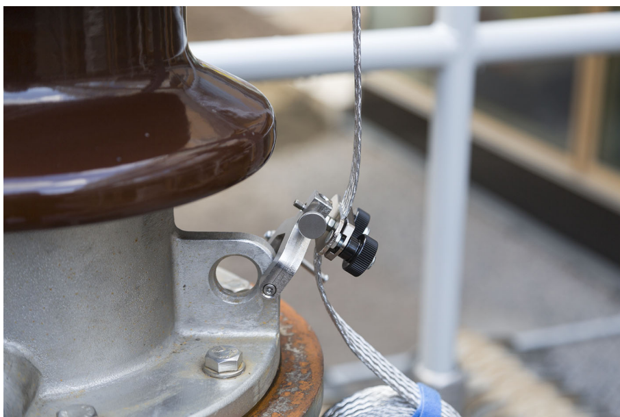
Joonis 4-6: Kruviklambri kinnitamise alternatiivne meetod
