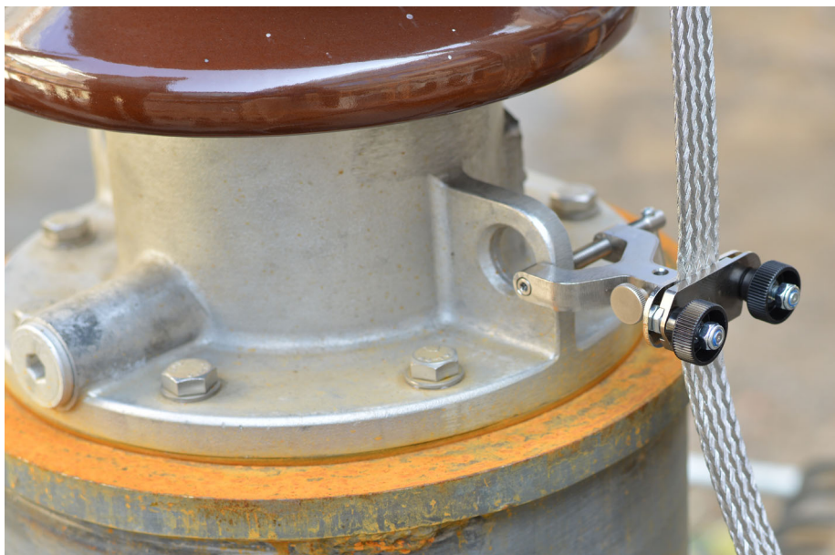
Joonis 4-5: Kruviklambri kinnitamine
