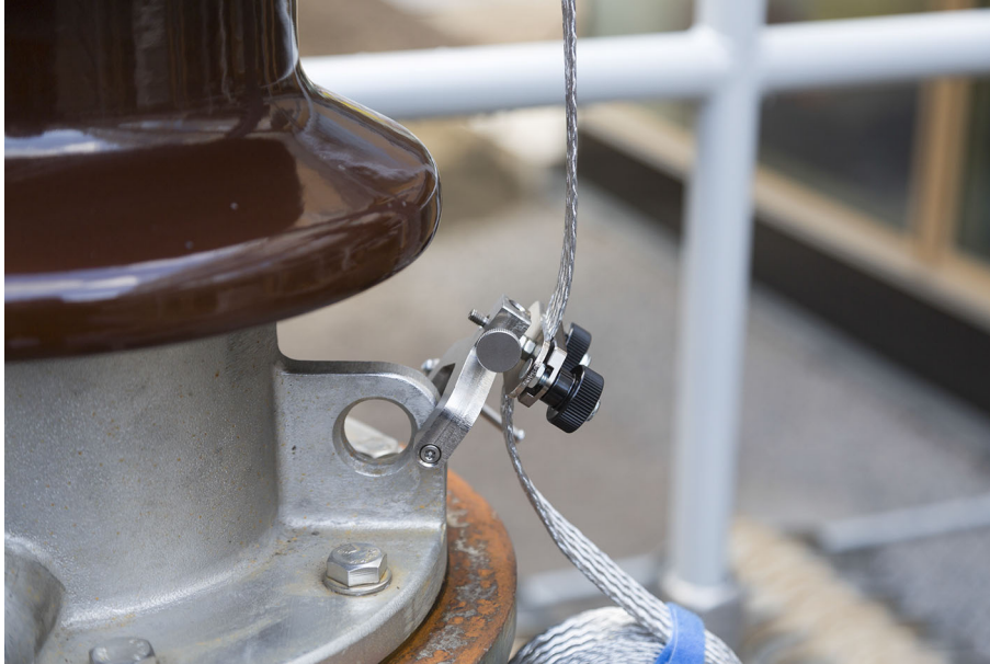
Şekil 5-6: Vida klampını sıkmanın alternatif yöntemi
