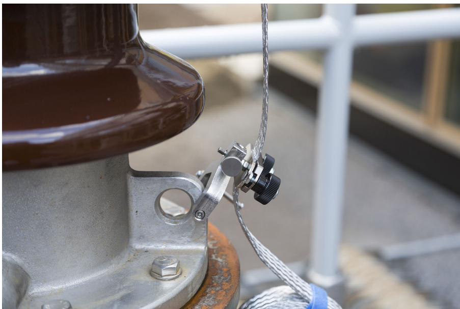
Abbildung 5-6: Alternative Möglichkeit zum Anbringen der Schraubklemme
