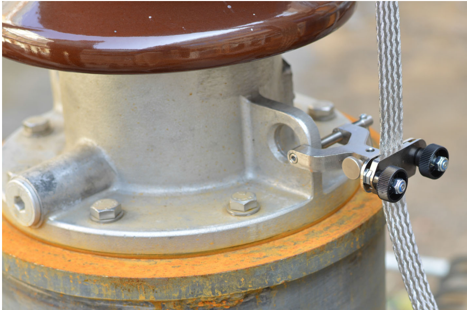
Abbildung 5-5: Anbringen der Schraubklemme
