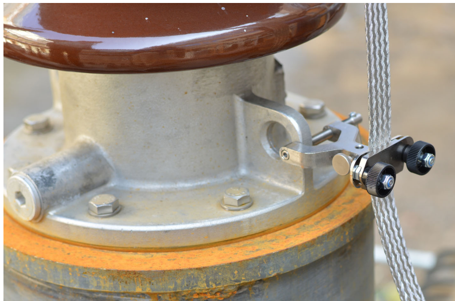
图 4-5：固定螺纹夹
