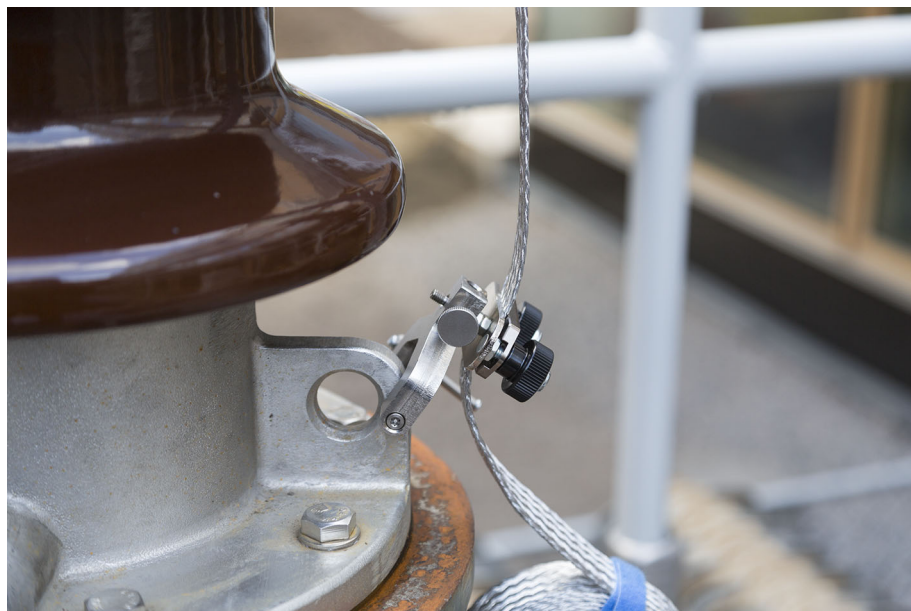
图 4-6：固定螺纹夹的另一种方式
