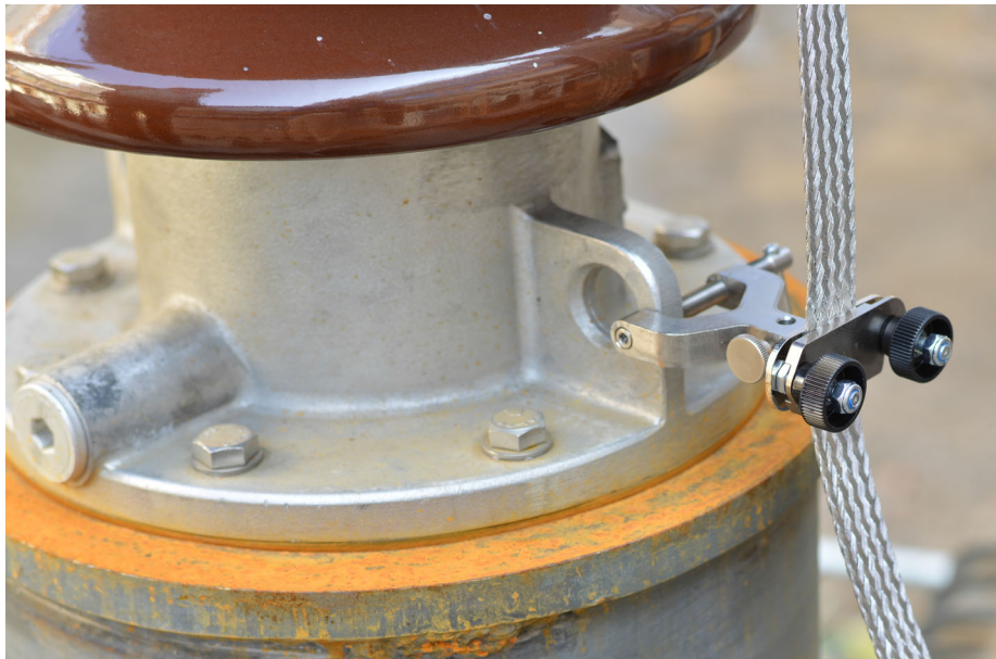
图 5-5：固定螺纹夹
