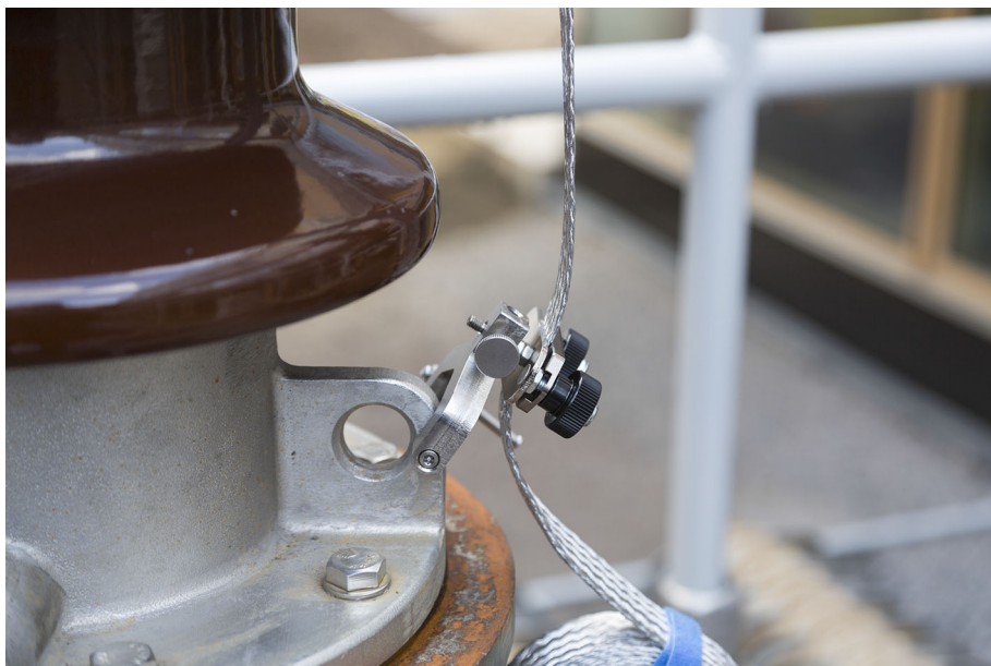
图 5-6：固定螺纹夹的另一种方式
