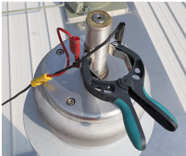
Рис. 4-1 Зажим Кельвина на высоковольтном вводе
