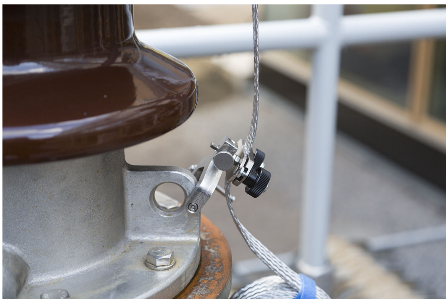
4-6. ábra: A csavaros szorító így is rögzíthető.
