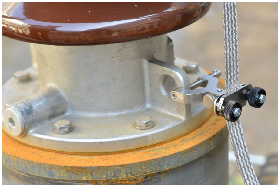
4-5. ábra: A csavaros szorító rögzítése
