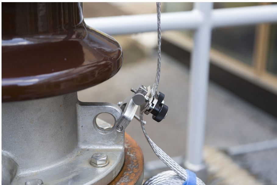
Afbeelding 4-6: Alternatieve manier van vastzetten van de schroefklem
