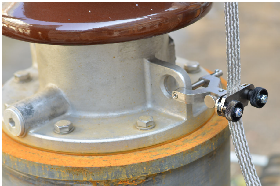
Afbeelding 4-5: De schroefklem vastzetten
