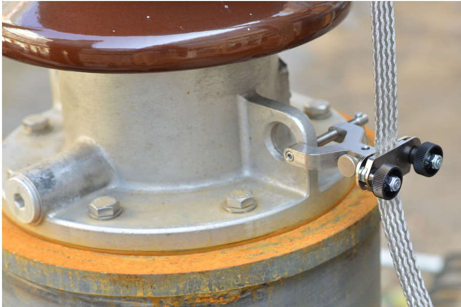
Abbildung 4-5: Anbringen der Schraubklemme
