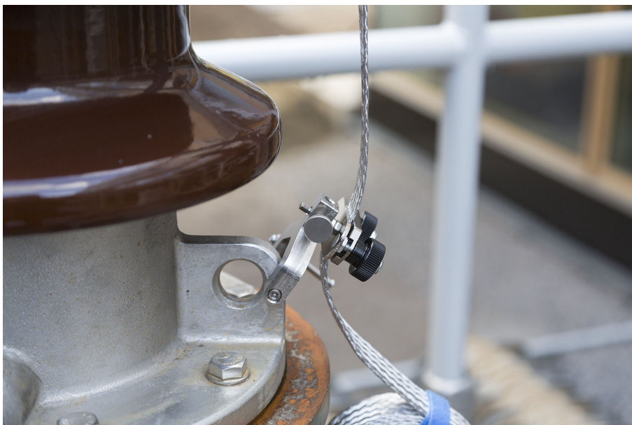
Abbildung 4-6: Alternative Möglichkeit zum Anbringen der Schraubklemme
